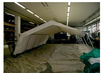
9. Das Gerüst nun über das Achsmaß in der Länge und Breite genau ausrichten. Anschließend die Zeltheringe durch die Löcher der Kunststofffußplatten in den Boden einschlagen. Die Zeltplane zusätzlich über die Ringschlaufen mit Heringen im Boden verankern.
